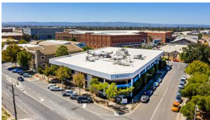
296 St. Vincent Street, Port Adelaide SA
